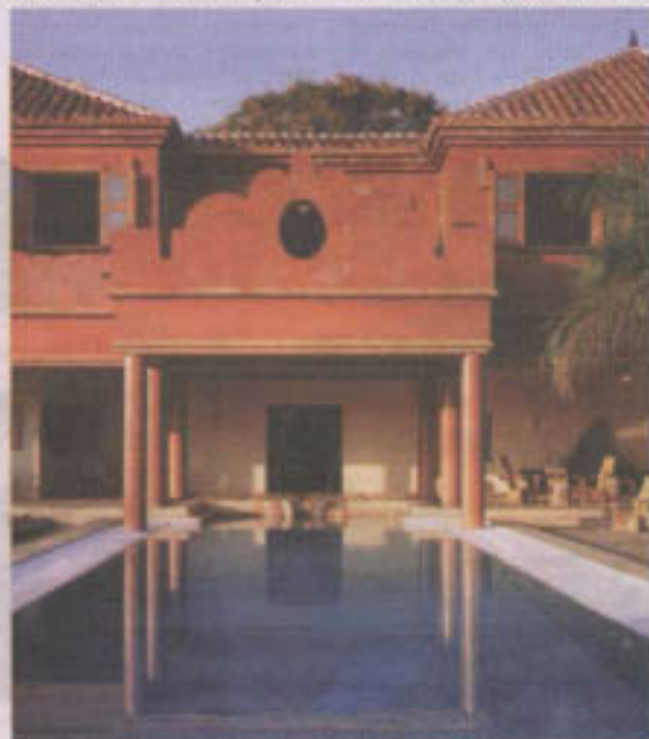
Casa diseñada por el arquitecto Gilles Saint Gilles.
